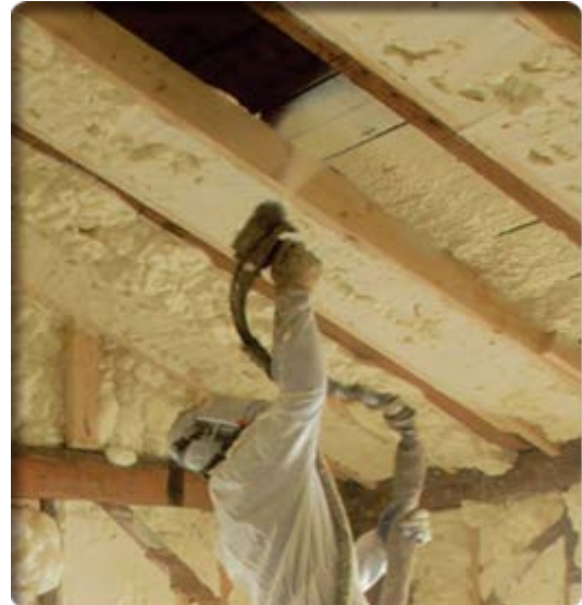
Fig 1 Isolering av skråtak med Icynene sprayskum Foto: Icynene
