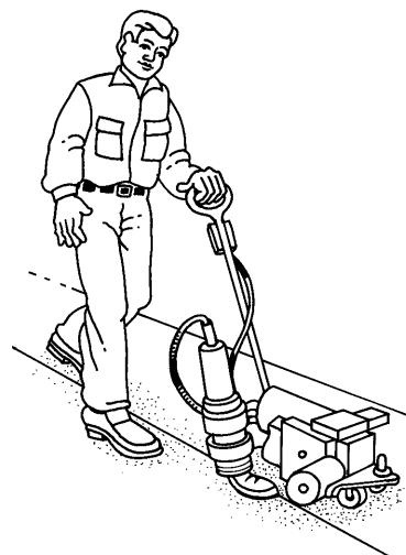
Fig. 1 Katepal Topp Tornado og Topp Tornado Hybrid festes mekanisk i omlegget som sveises med varmluft eller gassflamme.
