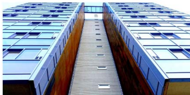
I Bergen står verdens høyeste trehus bygget av moduler. Og huset har naturligvis fått navnet "Treet". Foto: Utlån fra BOB.
