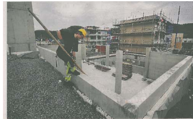
Selve byggeprosessen i et modulbygg inngår ikke i en godkjenning fra SINTEF Teknisk Godkjenning. Bildet viser bygging av leiligheter på Utleir med moduler fra en fabrikk i Latvia. Foto: JENS PETTER SØRRAA
