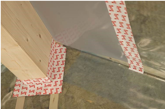
Fig. 8: Isola AS Eksempel på bruk av Isola FLEX Dampsperr Tape for tetting rundt bjelkegjennomføring.
